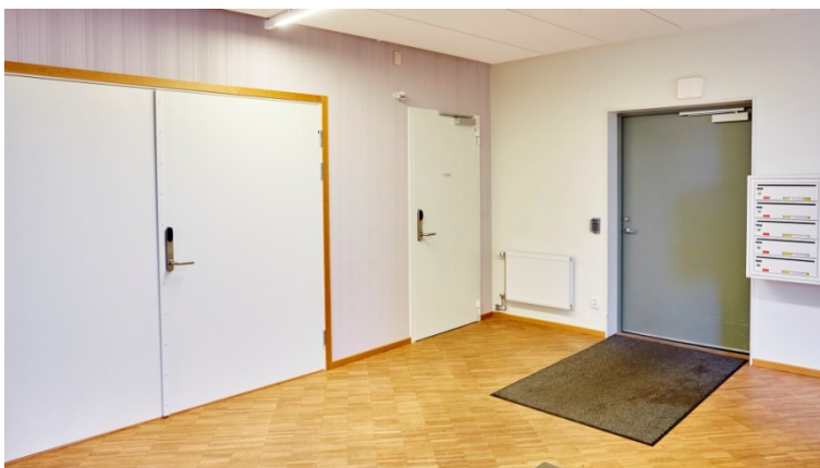
Dörrar på entréplan innan miljöåtgärd.
