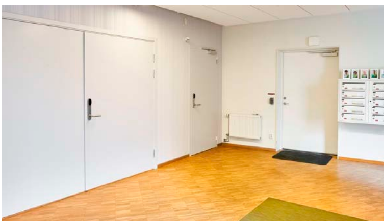
Dörrar efter miljöåtgärd. Dörrar som i huvudsak ska användas av personal målas i samma nyans som väggen.
