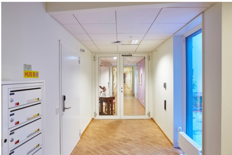
Dörr till hemvist innan åtgärd.
