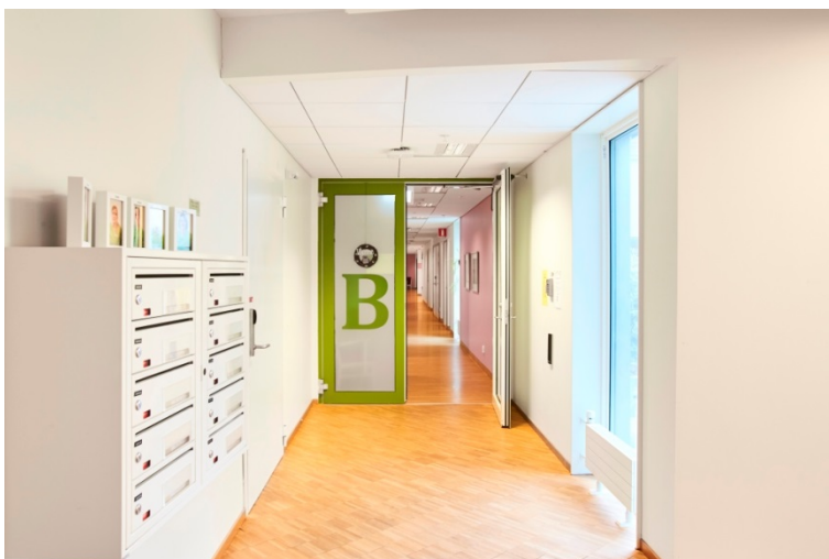
Dörr till hemvist efter åtgärd. Dörr markerad i tydlig kontrastfärg, glaspartier frostade samt tydlig markering av hemvistens bokstav.
